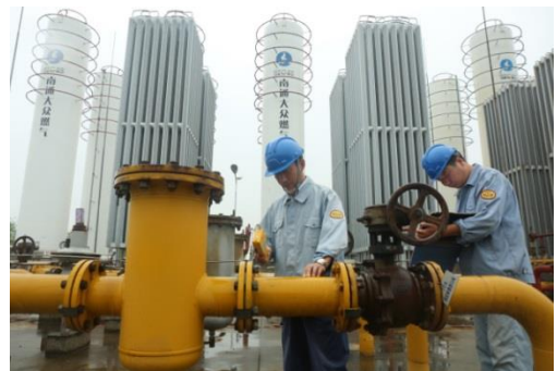
南通大众燃气检修
