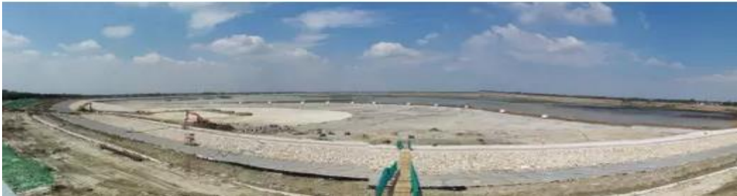
2016年3月，承接上海市重大民生工程金泽水库原水项目
